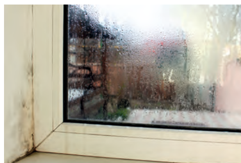
Εικόνα 9.1Β Υγραποίηση και δημιουργία μούχλας
