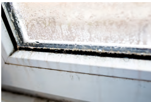
Εικόνα 9.1Β Υγραποίηση και δημιουργία μούχλας
